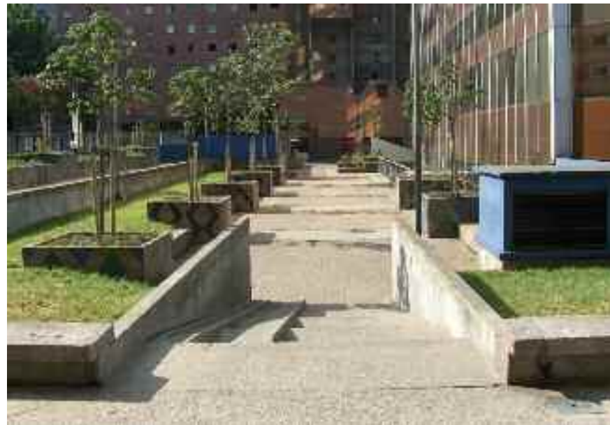
Dalle de l'îlot 27 ; la rue n'est plus, les piétons empruntent un chemin protégé
