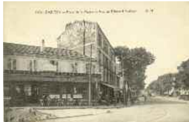
Place de la mairie en travaux et avenue Édouard-Vaillant
